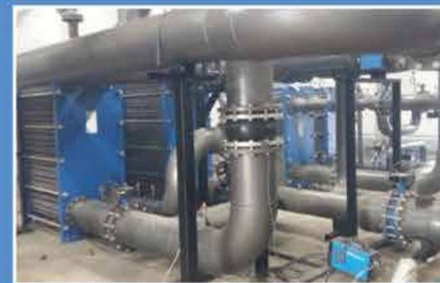
«Строительство тепловой сети в г. Борисове от УТ6 в районе котельной по ул. Братьев Вайнрубов до района теплоснабжения котельной №5 по ул. Серебренникова со строительством ЦТП», ЦТП, установка оборудования
