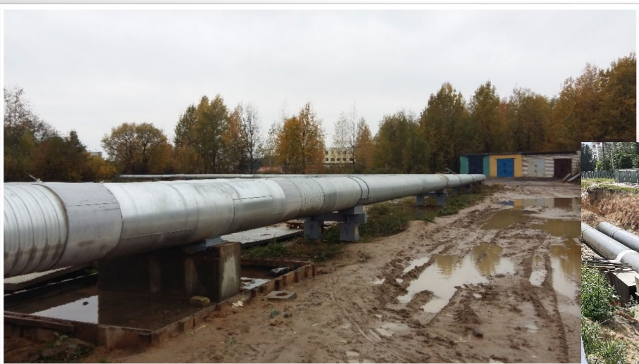
«Котельная по ул.Сосновая в г.Костюковичи» 1 очередь строительства. Внеплощадные сети теплоснабжения 2Ду500 мм, надземная прокладка
