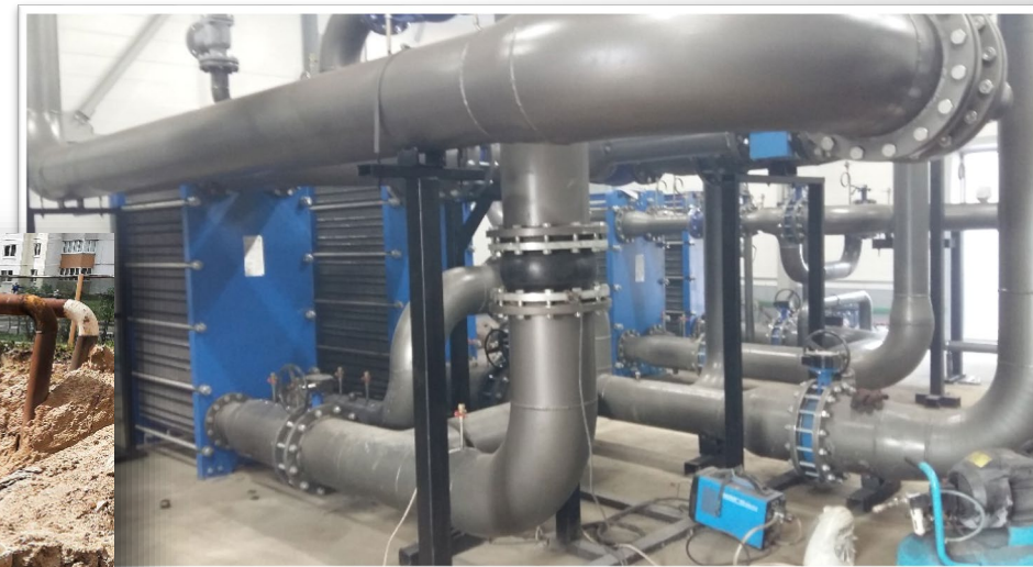
«Строительства тепловой сети в г.Борисове в районе котельной по ул.Братьев Вайнрубов до района теплоснабжения котельной №5 по ул.Серебренникова со строительством ЦТП», ЦТП, установка оборудования
