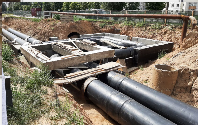
«Реконструкция тепловой магистрали с применением ПИ-труб ТМ-01 на участке от ТК-0118 до точки в районе ТК-0127 по ул. Ульяновской в г.Бобруйске», 2Ду800 мм, П-образный компенсатор
